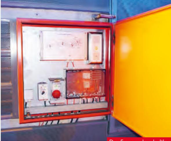
Der Feuerwehrschaltkasten ist erste Anlaufstelle für Einsatzkräfte. Notausstiege – wie hier am Kronprinzenufer – führen nach oben. „Querschläge“ heißen die Brandschutztüren, die beide Röhren verbinden. Eine Ausweich-Leitwarte ist in unterirdischen Betriebsgebäuden eingerichtet.
